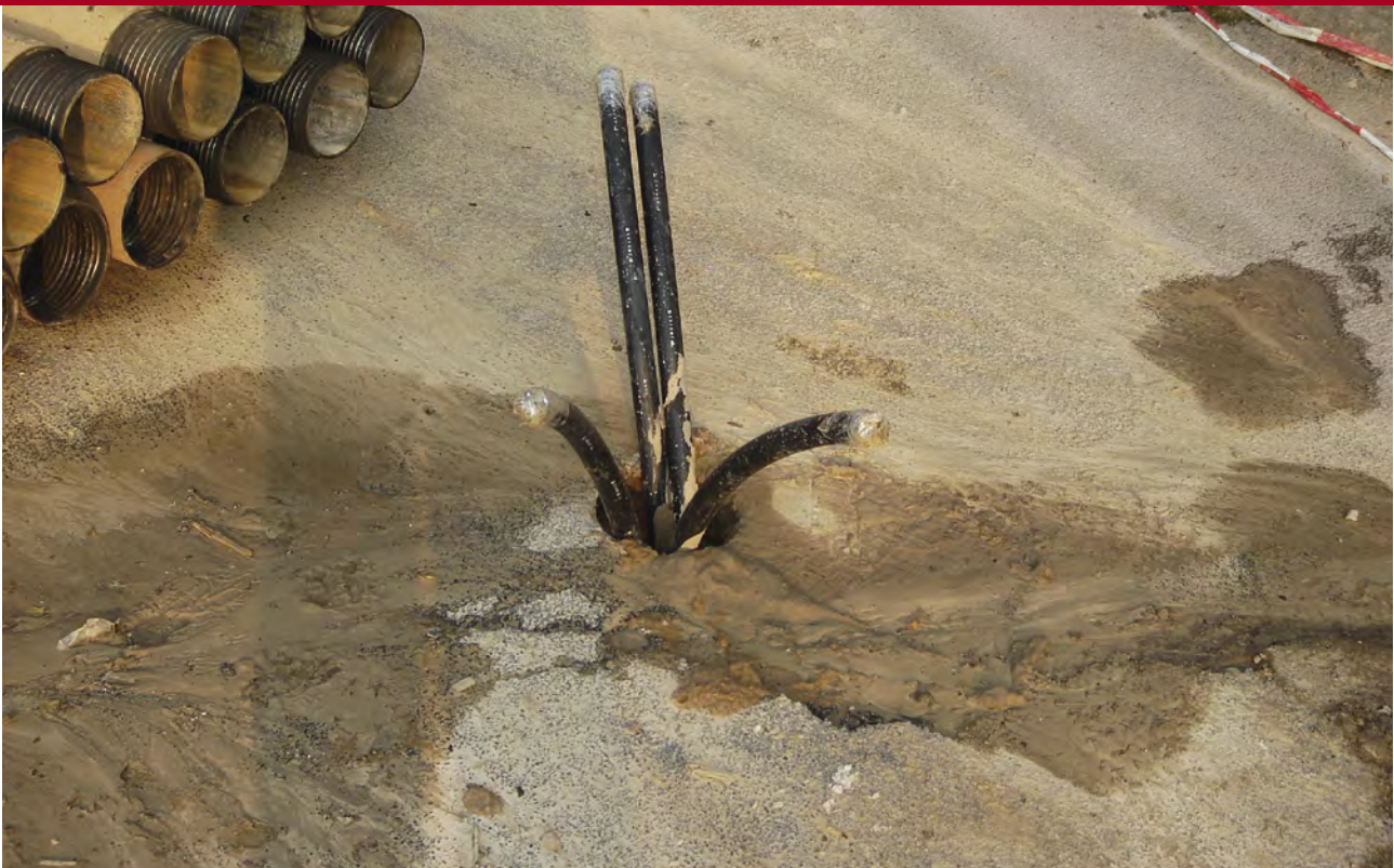
Hier kommt die Erdkühle raus
