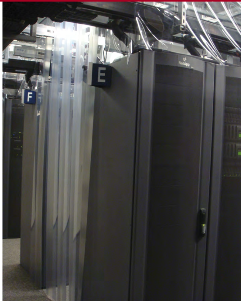
Kunststoffvorhänge zur Trennung kalter und heißer Gänge
